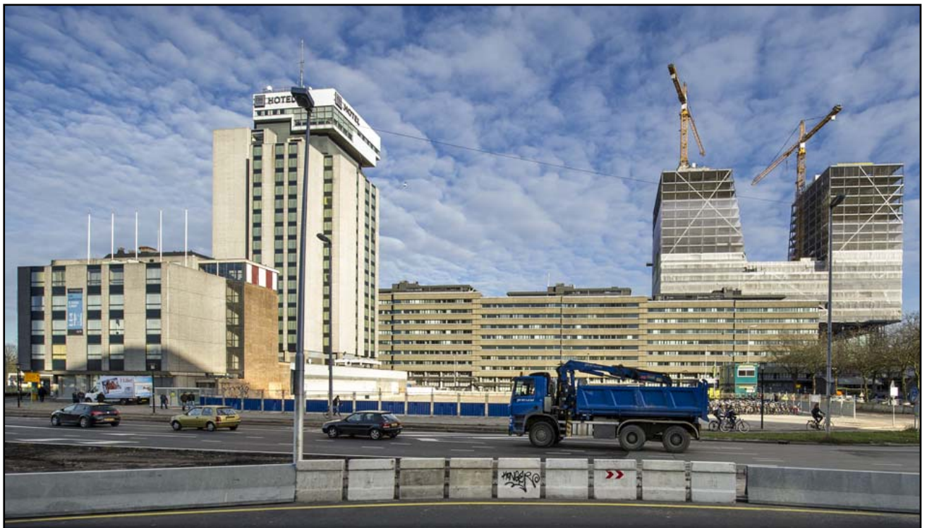
Aan de rechterkant van het NH-hotel wordt de tijdelijke eindhalte van de tram gebouwd
