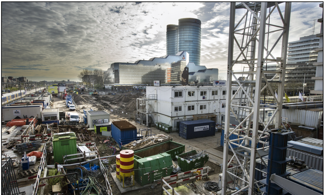
Net achter de witte bouwketen wordt het tijdelijk Busstation west gebouwd
