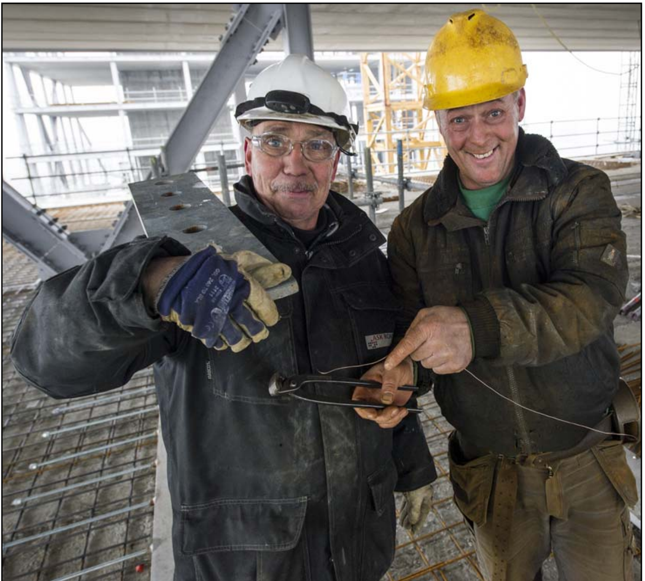
Bouwwerkers aan het werk in en aan het Stadskantoor
