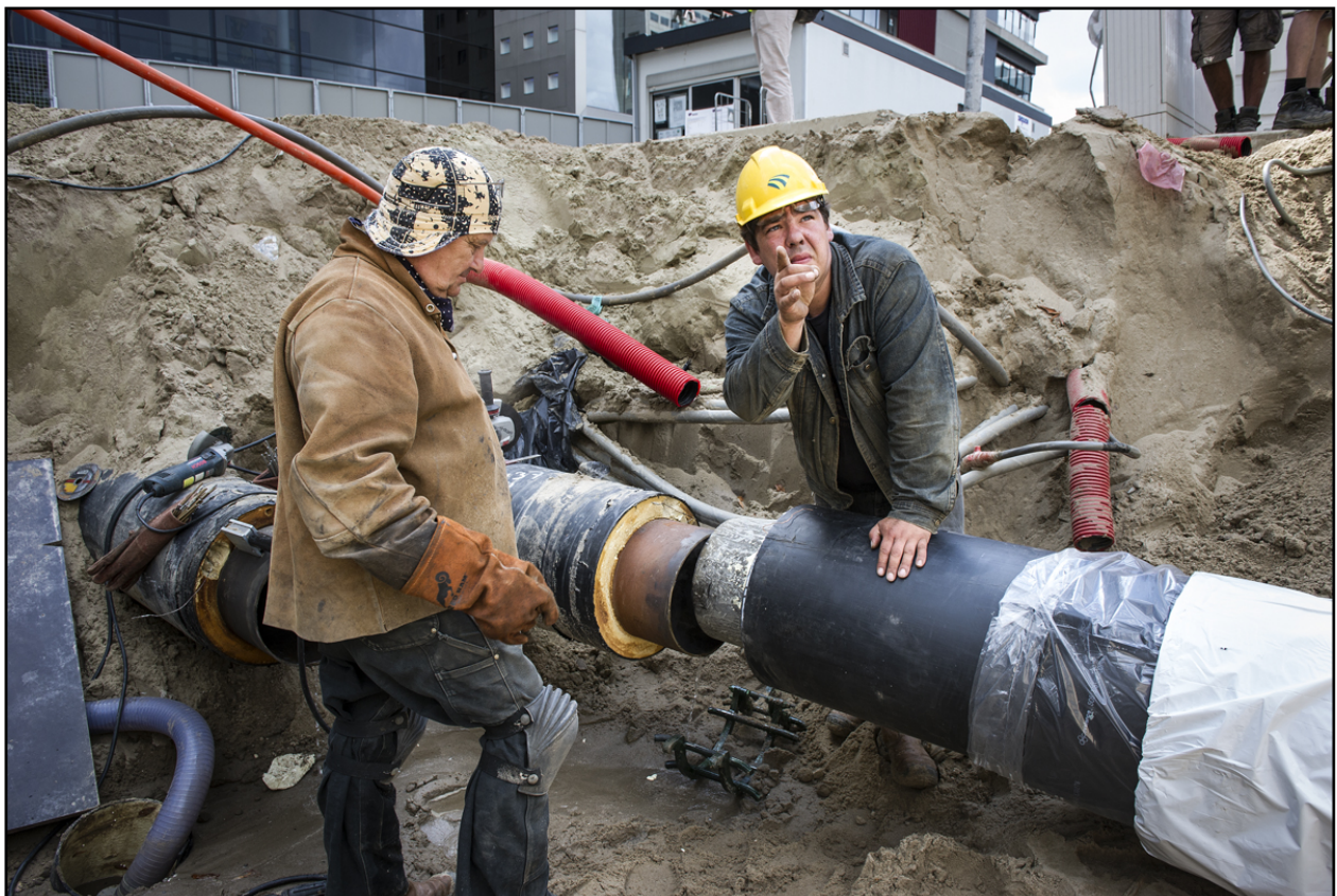
Het aanleg van kabels en leidingen onder het Jaarbeursplein
