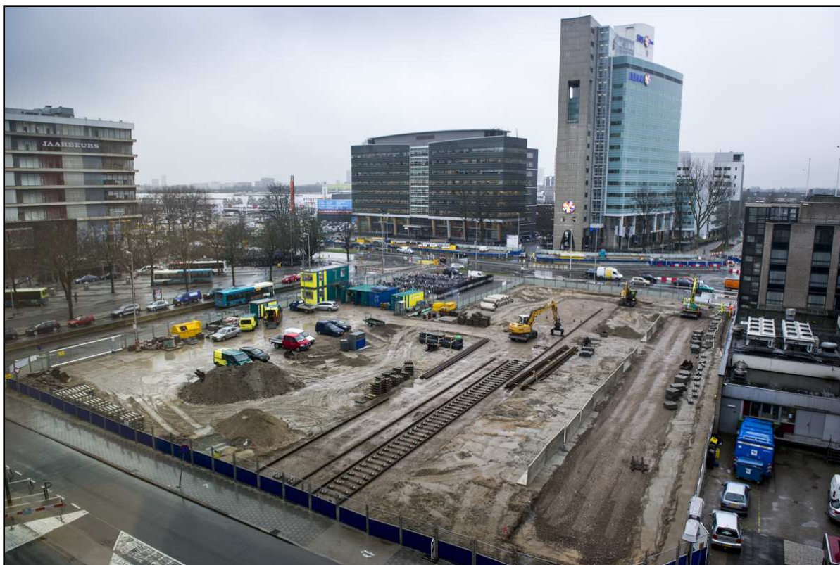
Jaarbeursplein; aanleg tijdelijke eindhalte van de tram
