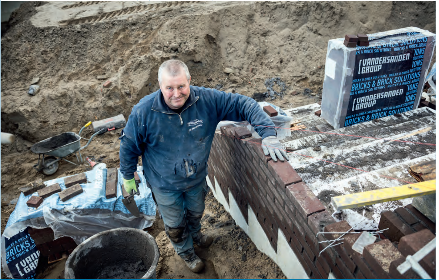
De kademuren zijn gemetseld: klaar voor het water
