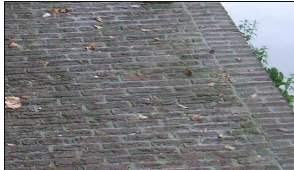
Lage kade met rollaag van metselwerk
