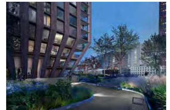
groene terrassen: Woontoren Casanova, Rotterdam - Barcode Architects
