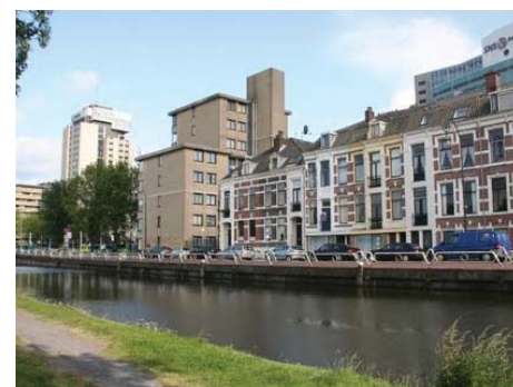
zicht over de bestaande Leidsche Rijn
