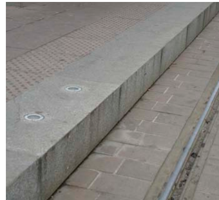
Verhoging tramperron door hoge band
