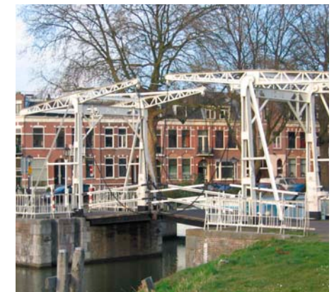
Bestaande Abel Tasman ophaalbrug
