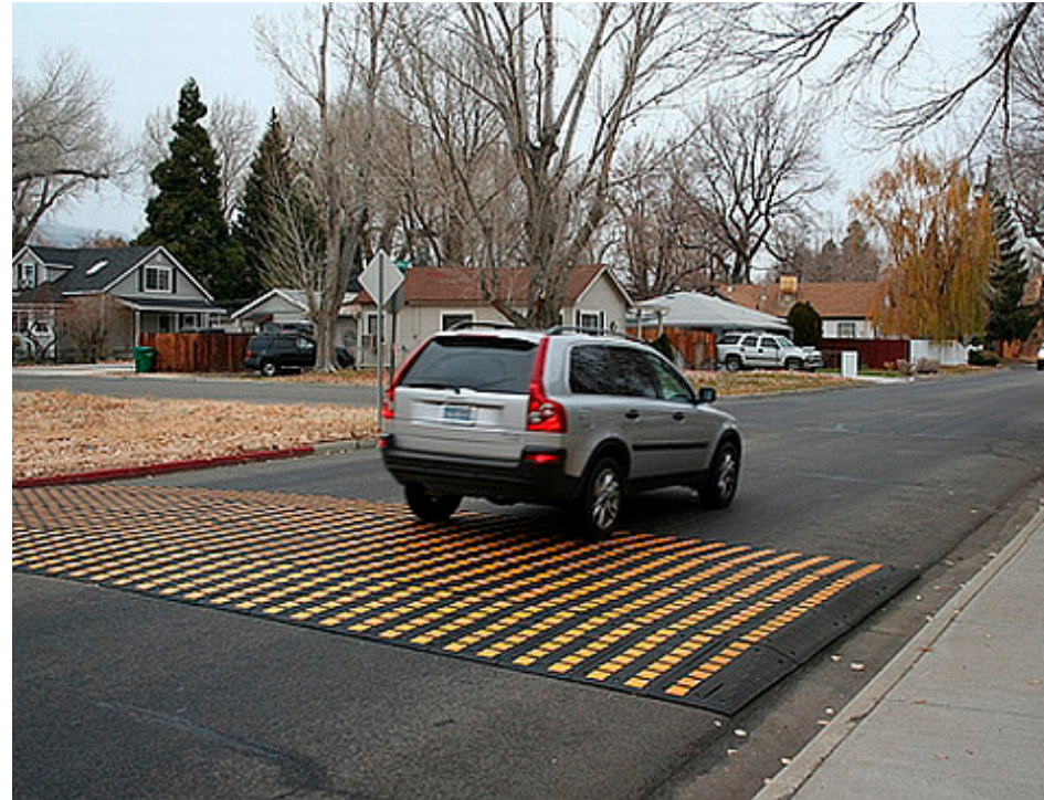
Energie opwekkende verkeersdrempel
