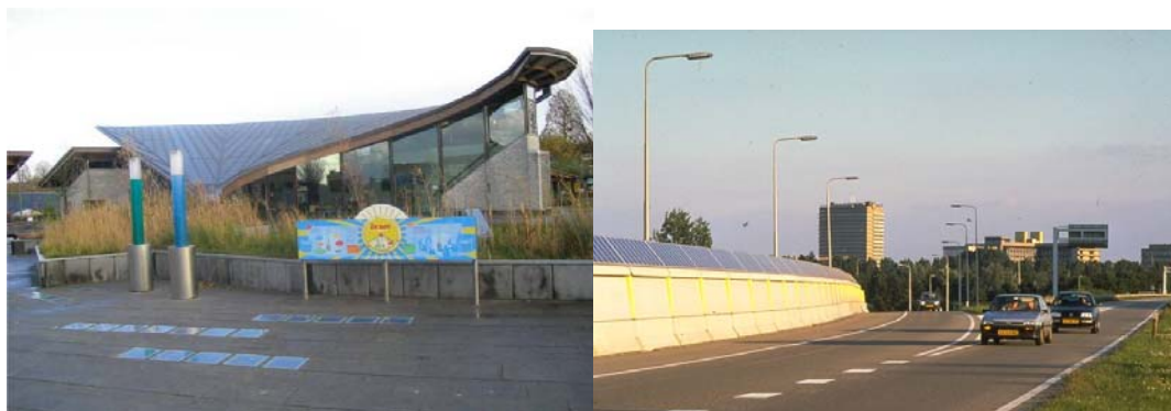
Fig. 36: zonnetegelplein en geluidswal met zonnecollectoren
