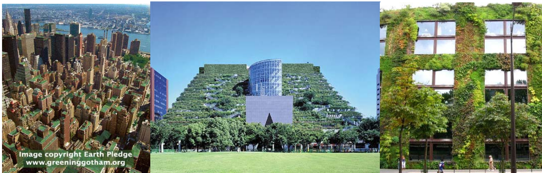
Fig 12: groene daken en gevels
