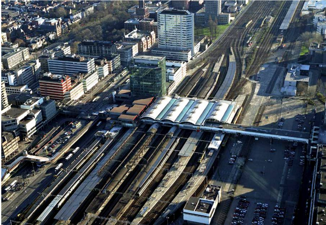
Fig. 5: de huidige OV Terminal
