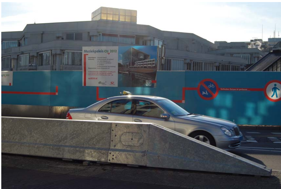
Fig. 2: werkzaamheden bij Vredenburg
