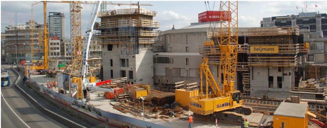
Zicht op de bouw van het Muziekpaleis
