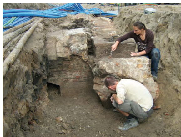
Fig. 5.1.2: archeologen van ADC ArcheoProjecten aan het werk bij de funderingen van de noordoost toren van kasteel Vredenburg, begeleiding KPN, juli 2007.
