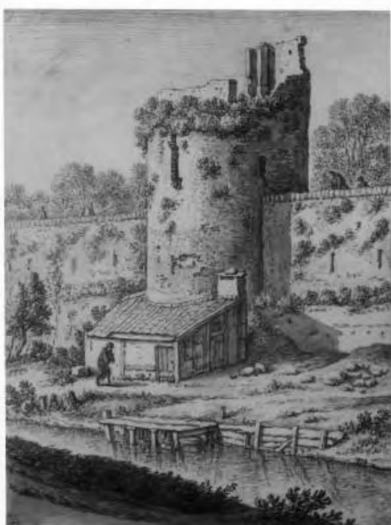
Fig. 5.2.4: de tot ruïne vervallen Snijderstoren met een schuur ertegenaan gebouwd. Op de voorgrond de singelweg en de stadsbuitengracht. Bron: Utrechts Archief, catalogusnr. 36303.
