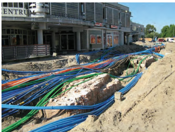
Fig. 5.1.1: in juli 2007 heeft KPN letterlijk honderden kabels en leidingen gelegd langs Muziekcentrum Vredenburg.
