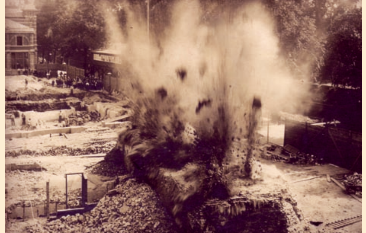
▲ Het laatste bovengrondse deel van Vredenburg werd in 1919 gesloopt voor de aanleg van een busstation.
