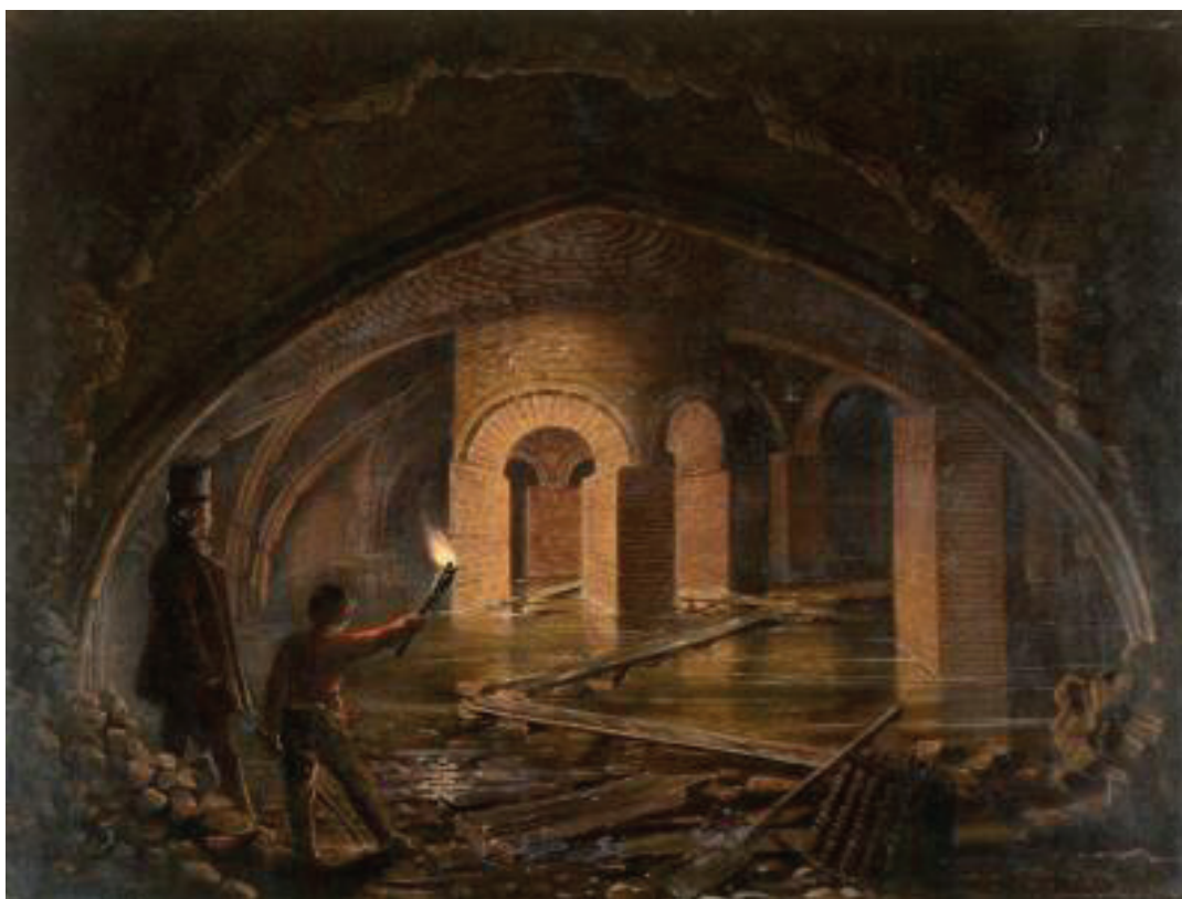
Fig. 5.1.10: de onderste verdieping van de noordwestelijke toren van Vredenburg, met in het midden de later ingebouwde kolommen ter ondersteuning van de molen De Eendracht. Bron: Utrecht Archief, catalogusnr. 30951.
