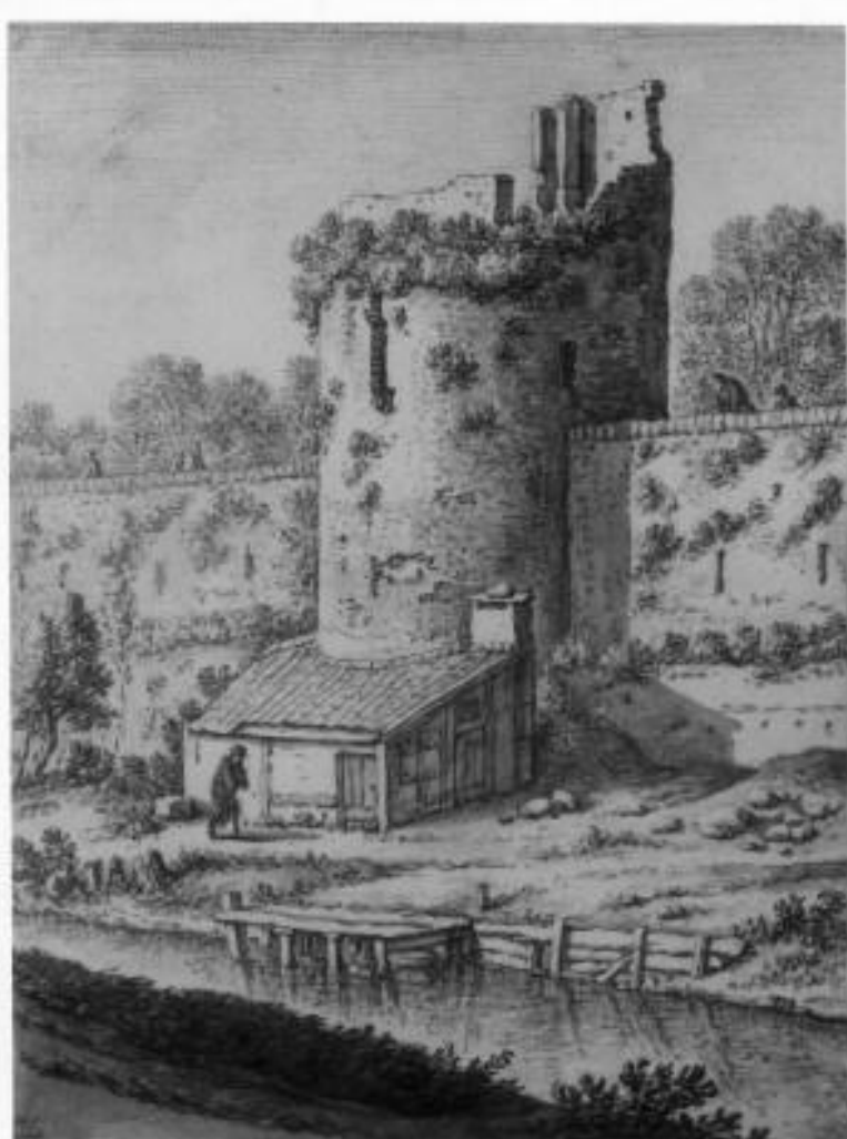
Fig. 5.2.4: de tot ruïne vervallen Snijderstoren met een schuur ertegenaan gebouwd. Op de voorgrond de singelweg en de stadsbuitengracht. Bron: Utrechts Archief, catalogusnr. 36303.
