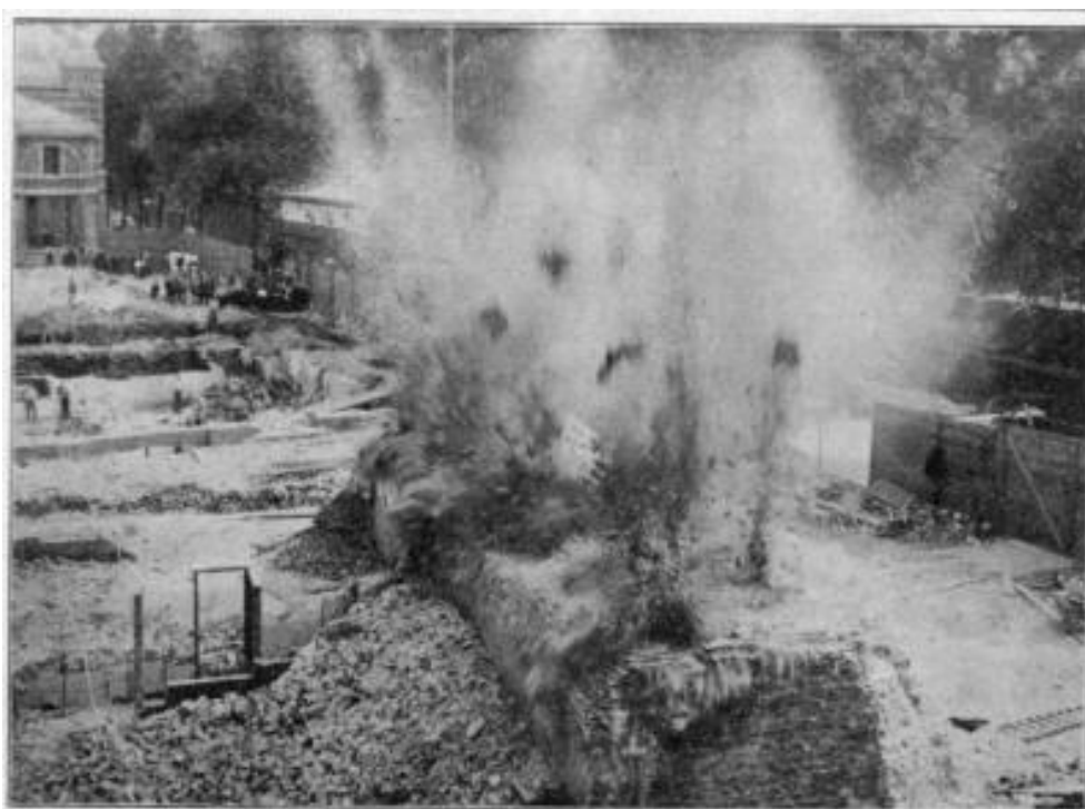
HET GEREEDMAKEN VAN HET TERREIN VOOR DEN BOUW VAN EEN EERSTE VAST JAARBEURSGEBOUW TE UTRECHT Een oude muur van het voormalige kasteel Vredenburg wordt met dynamiet geamoveerd
