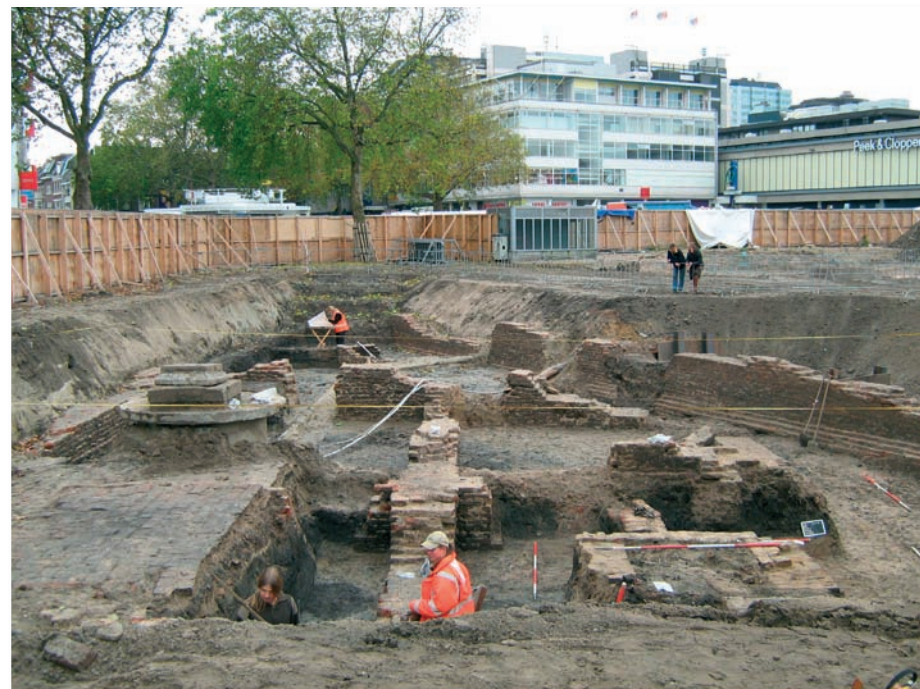
Afbeelding 3.4. De opgraving van De Teerling, oktober / november 2007. De muur met bocht uiterst rechts is de grachtmuur van kasteel Vredenburg. De overige muren behoren tot het laatmiddeleeuwse dubbelhuis van orgelbouwer Gerrit Petersz. Stam. De opgraving was dagelijks opengesteld voor publiek en heeft veel bezoekers getrokken.
